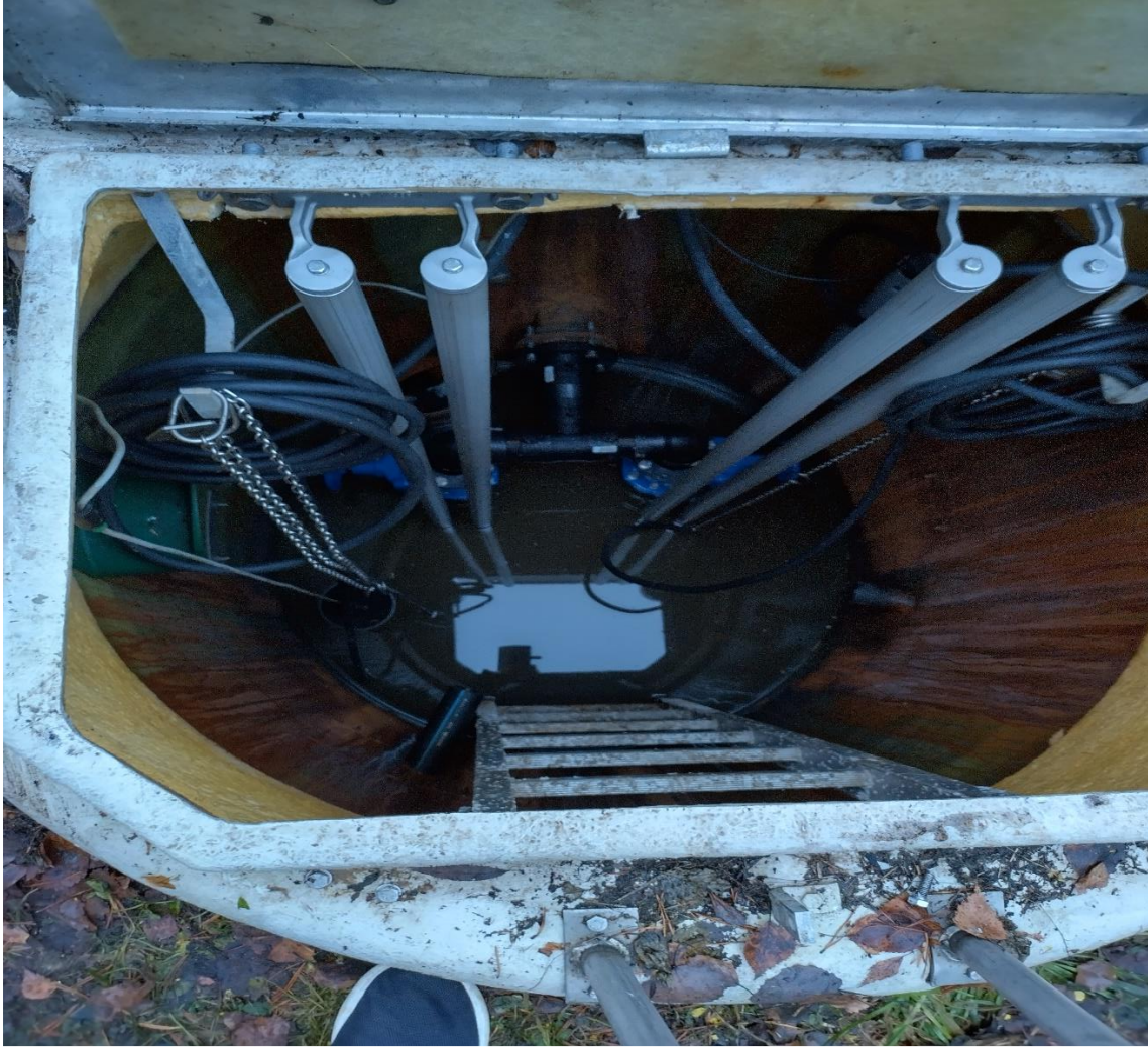
Siirlahden jätevedenpumppaamo saneeraus.
